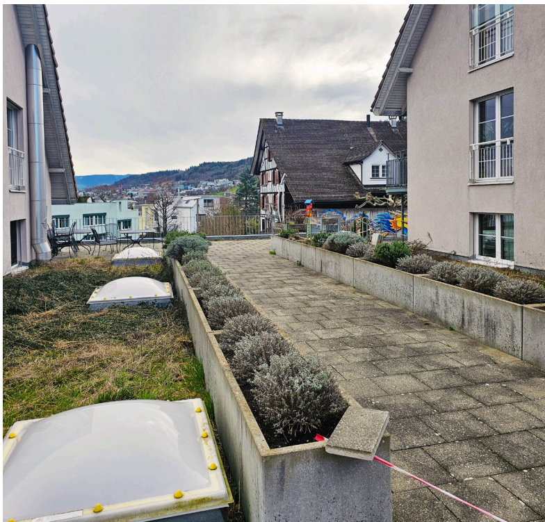
Dachterrasse vor der Sanierung mit den Grünflächen
